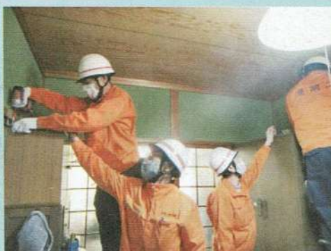
家具転倒防止金具取り付け作業
