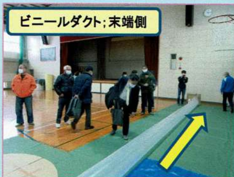
排気用ダクト & 送風機
