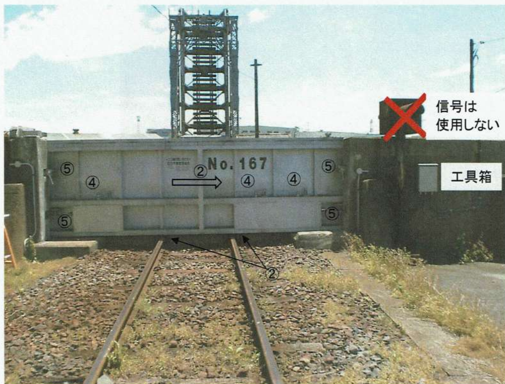
アルミ合金製横引き線路上 (No.146, 167防潮扉)
